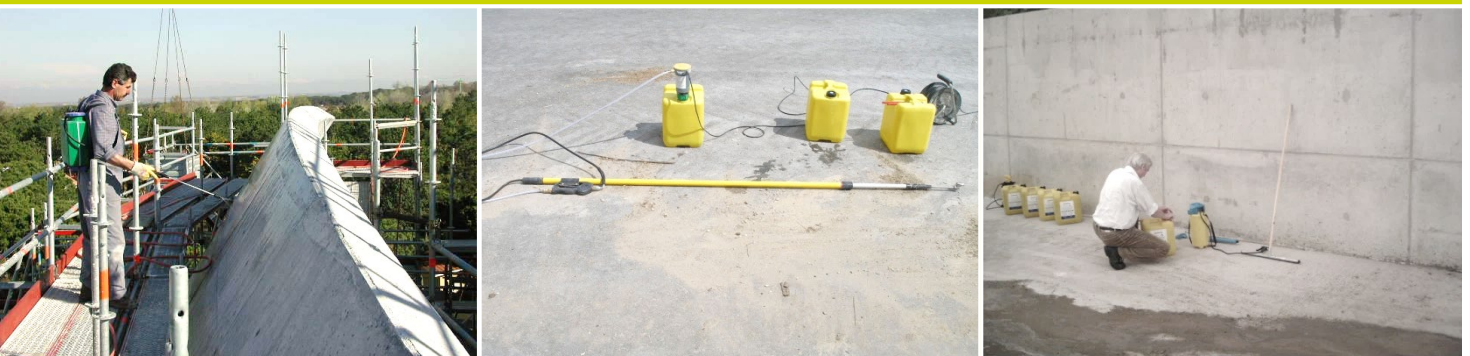
EverCrete® P - Applikation / Kanisterpumpe mit Lanze und 20 m Schlauch / Vorbereitungen
