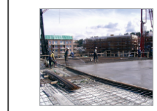
Auftragen des Betondichtungsmitels auf der Frischbetonoberfläche
