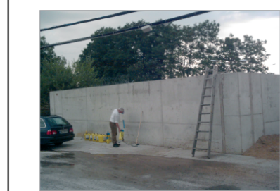
Behandlung von bereits ausgehärteten Betonflächen
