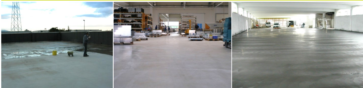
Parkdeck / Produktionshalle Elektrotechnik / Fußbodenerneuerung Parkhaus
