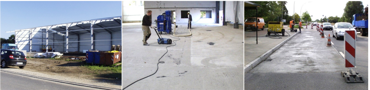
Hallensanierung in Hamburg / Busspuren erneuert in Hamburg durch Strabag
