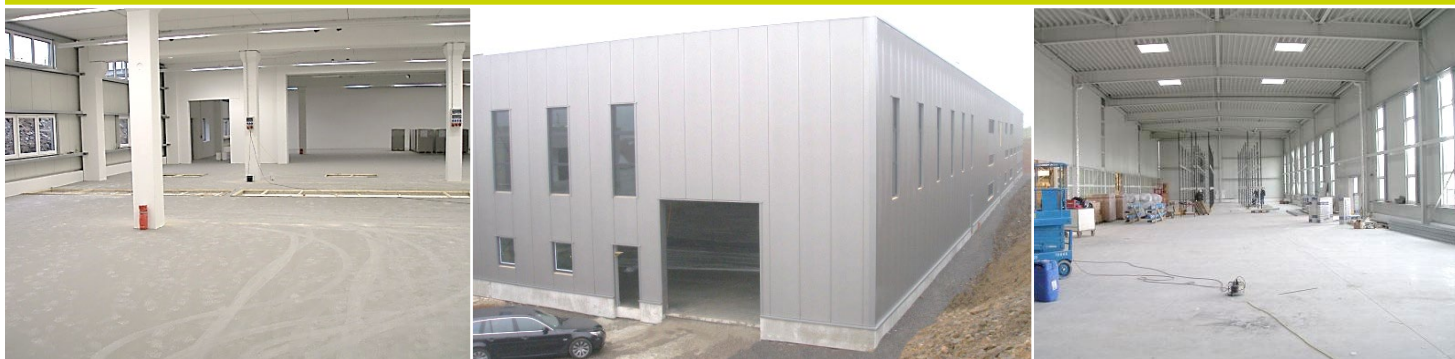
Industriefußboden im bergischen Land (Hartkorn geflügelt)
