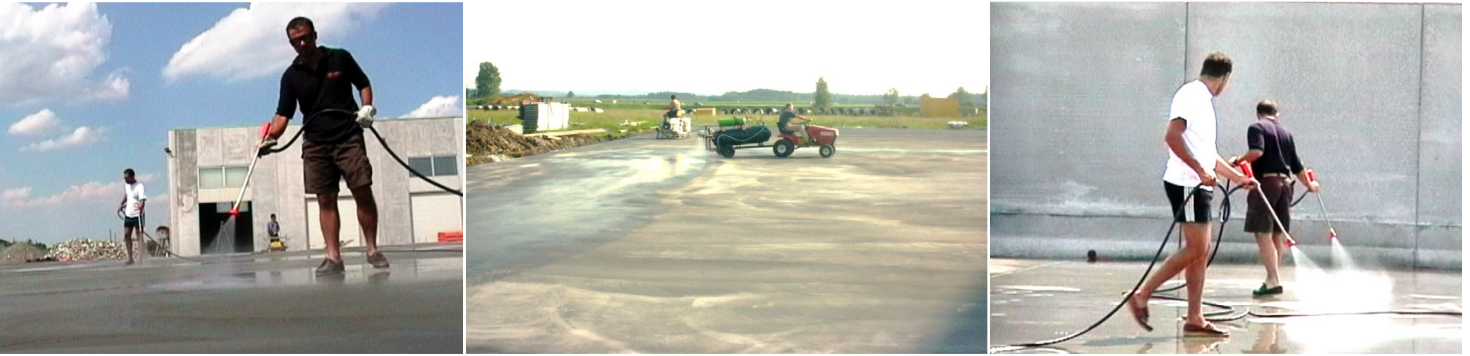
EverCrete® P - Anwendung für sehr große Flächen mit z. B. Kanisterpumpe
