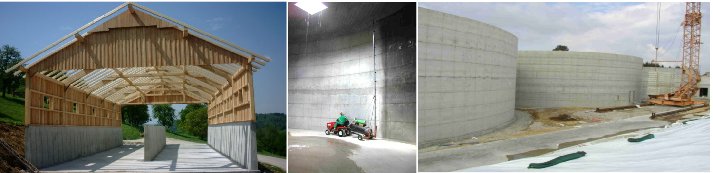
Fahrsilos und Biogasanlagen für Agrarbetriebe (Verbesserung gegen chem. Angriffen)
