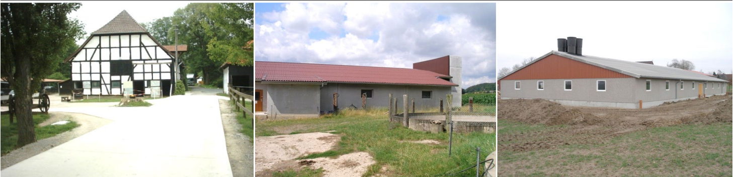
Fahrbahnsanierung (Frostschäden) und Ställe in Nord-und Westdeutschland (bei Wänden und Fußböden gegen Stauben und chem. Angriffe)
