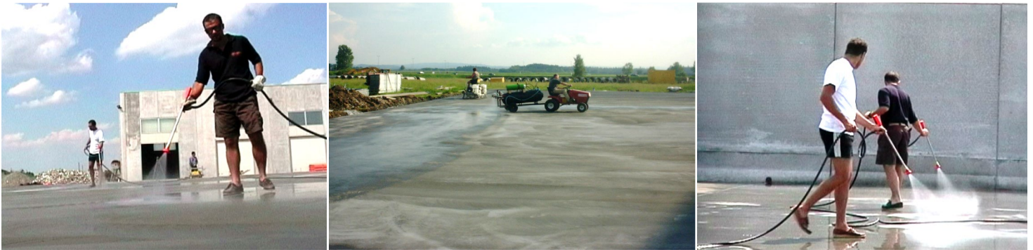
EverCrete® - Anwendung für sehr große Flächen mit z.B. Kanisterpumpe
