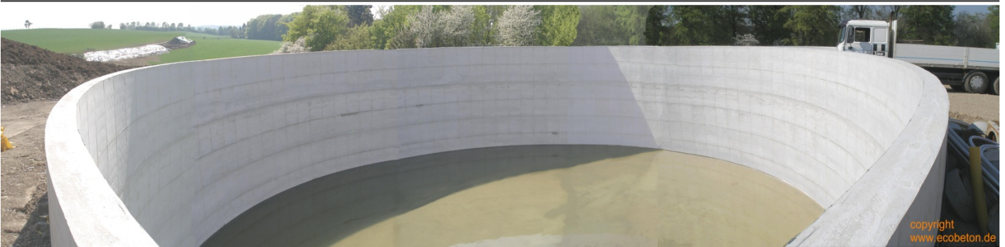
Biogasanlage in Westdeutschland
