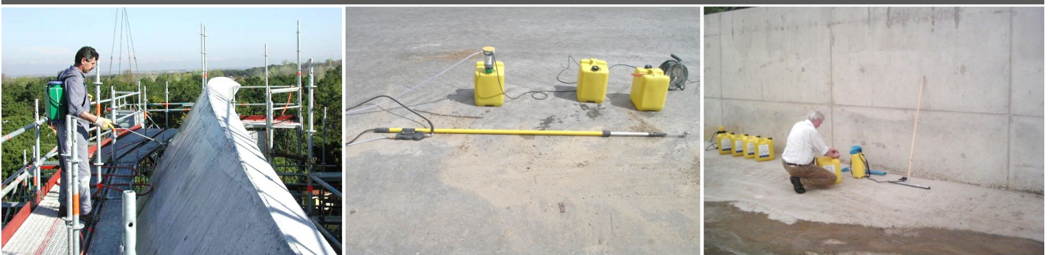
EverCrete® - Applikation / Kanisterpumpe mit Lanze und 20 m Schlauch / Vorbereitungen
